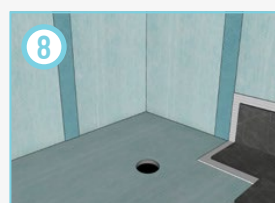
8 Приступить к монтажу настенной и напольной плитки
